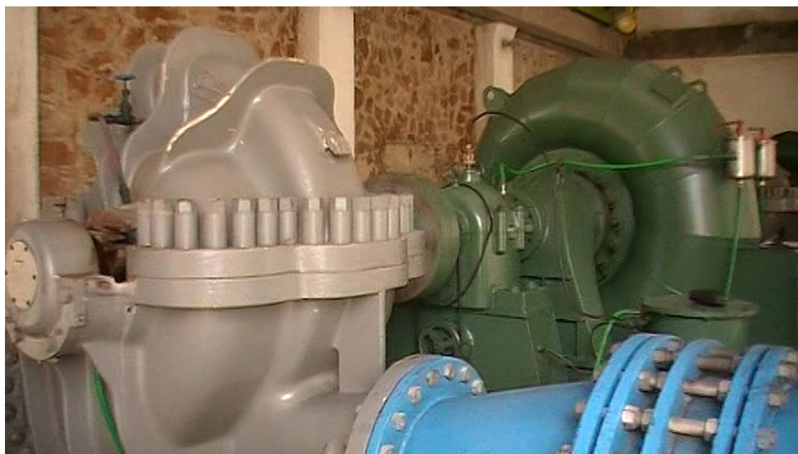
Figura 16.3 – Equipamento Turbina e Bomba (turbo/bomba) Orós/Feiticeiro
